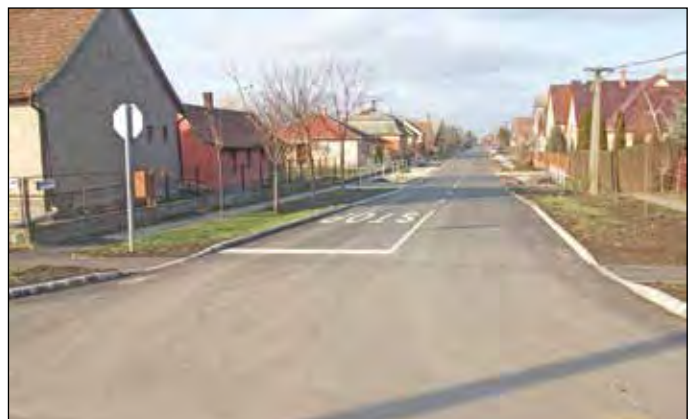
A Gárdonyi és Vadas utcák út- és csapadékvíz-elvezetés kiépítése megvalósult
