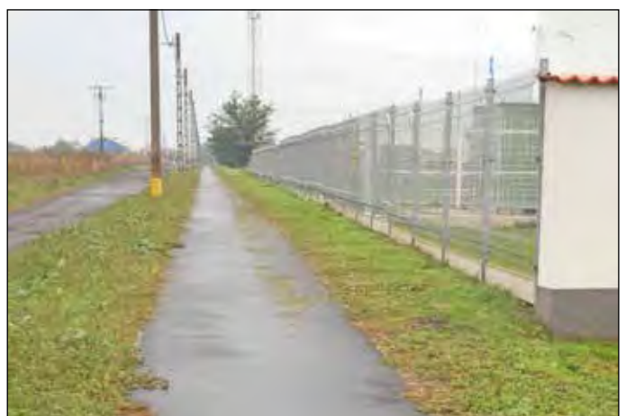
Megépült az ipartelepi járda és makadám út
