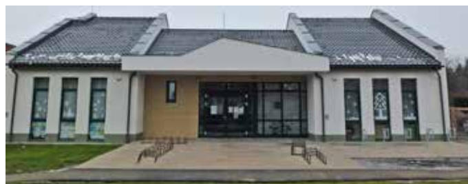
Elkészült a Bentlakásos Idősek Otthona építésének első üteme, melyben jelenleg az óvodában folyó munkálatok miatt az óvodások kaptak átmenetileg helyet
